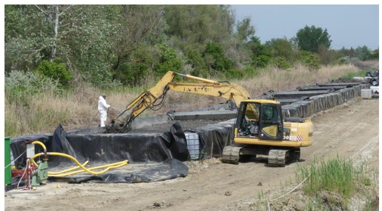
2. Vegyszer adagolás gépi keveréssel
