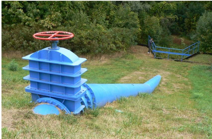
Tolózár az Atkai szivattyútelepnél
