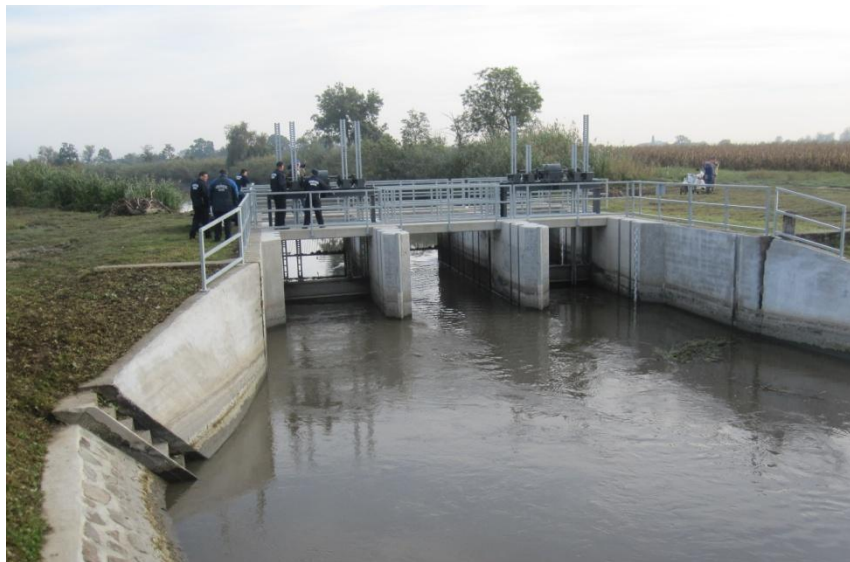
Belvízvédelmi műtárgy szemle
