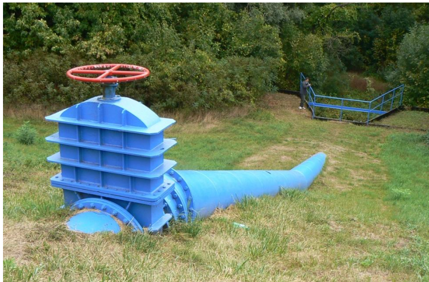
Tolózár az Atkai szivattyútelepnél
