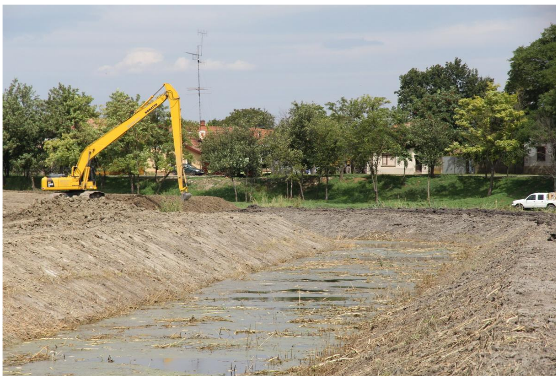
Tótkomlós belterületi víztározó építése
