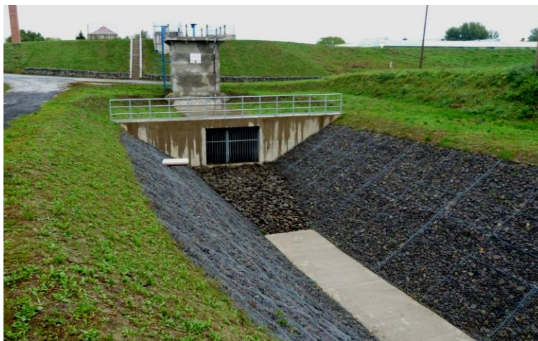
A Tápéi szivattyútelep vízdali elzárása
