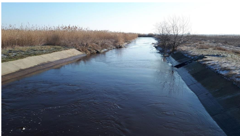
Pusztaszéli-csatorna az Erzsébet-Pusztai szivattyútelepnél
