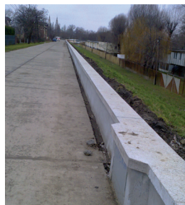
újraépített újszegedi parapetfal
