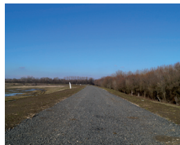
elkészült töltéskorona stabilizáció
