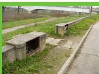
Kulisszanyílás és kábel szekrények
