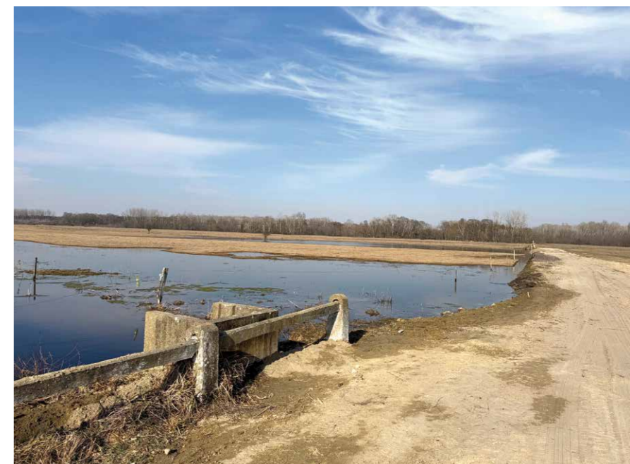
Kiskunmajsza-Marispuszta árasztás megvalósítása a Marisi-csatornából
