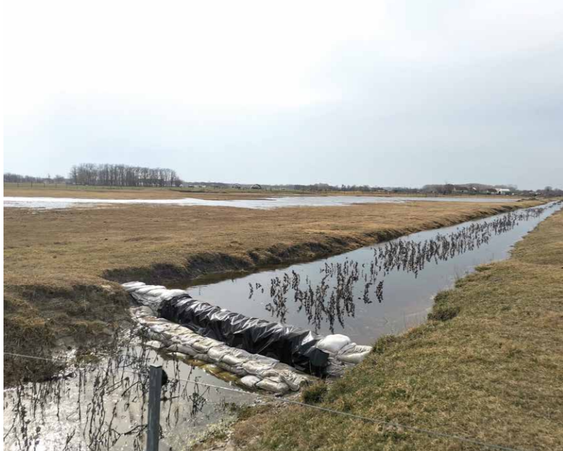
Domaszéki-főcsatorna homokzsákos zárásával megvalósított árasztás
