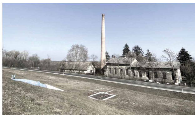
Szentesi szivattyútelep napjainkban
