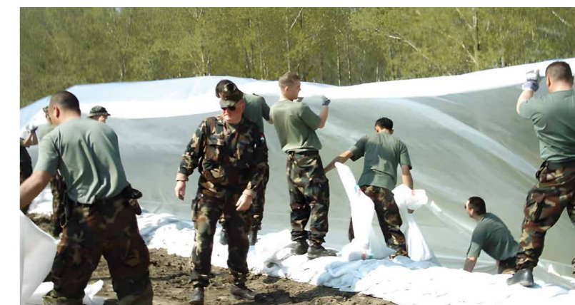
30. kép - Nyúlgát építés és hullámverés elleni védelem az Újszegedi őrjárásban
