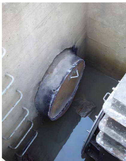
16. kép - Gyevífoki csatorna ideiglenes lezárása
