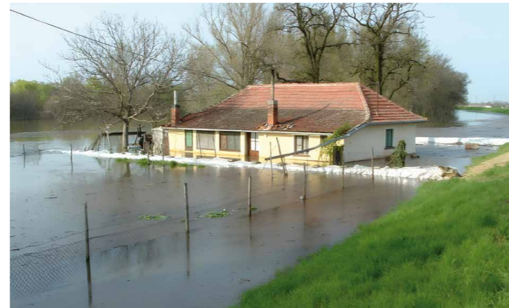
34. kép - Hullámtéri lakóingatlan bevédése
