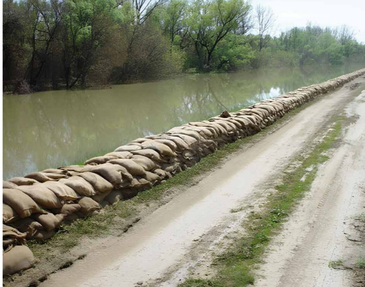
15. kép - Nyúlgát építése
