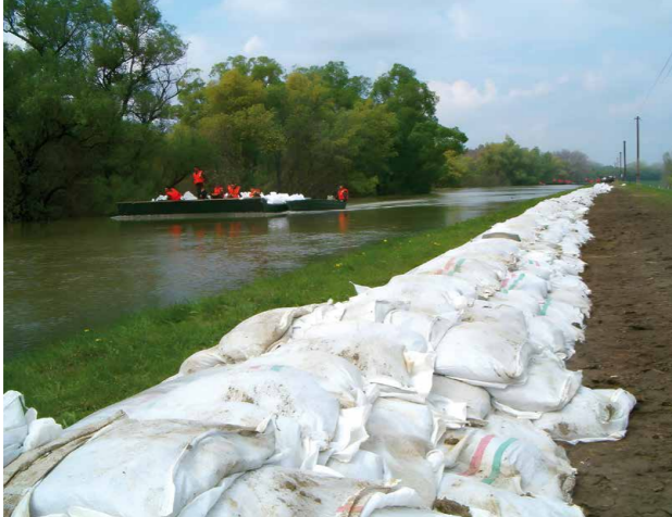
26. kép - Nyúlgát építés a 11.05 árvízvédelmi szakaszon
