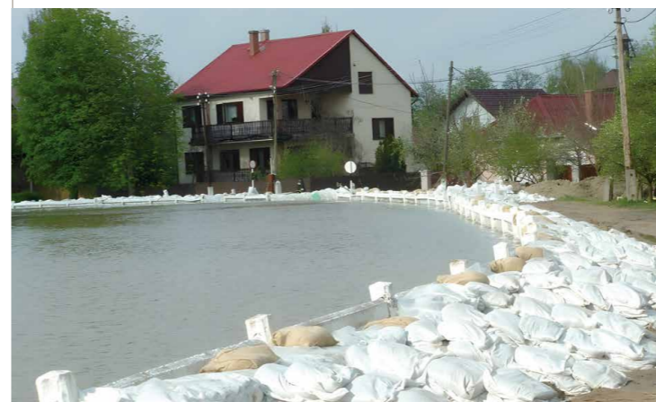
35. kép - Nyúlgátépítés Kunszentmárton belterületén
