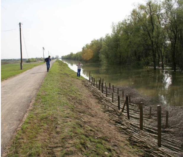
23. kép - Hullámverés elleni védelem rőzseművel
