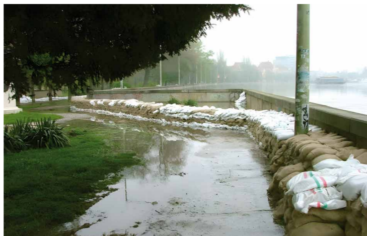
11. kép - Partfal mögötti ideiglenes magasítás kiépítése
