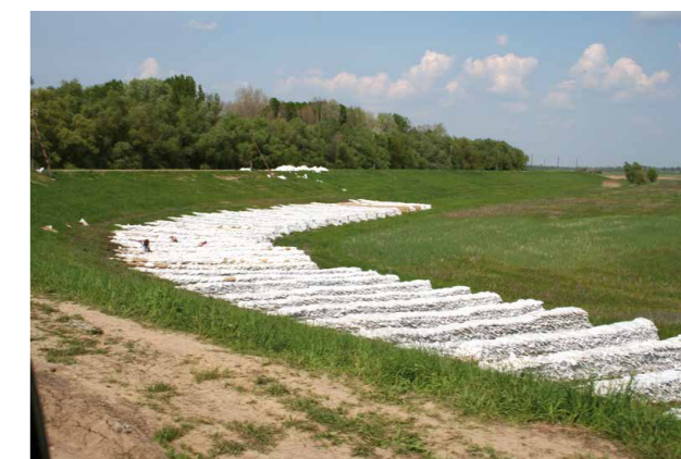
22. kép - Bordás megtámasztás a „bodzási útnál”
