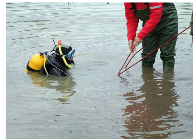
36. kép - Csapadékvíz kivezetés elzárása bűvár segítségével
