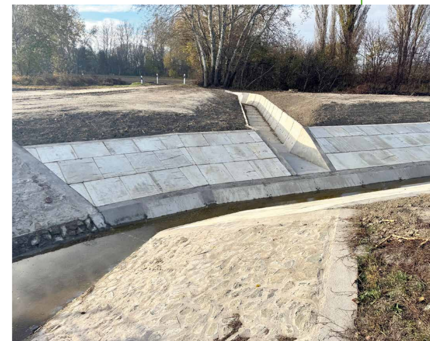
Kisivánszéki-csatorna becsatlakozásának burkolata
