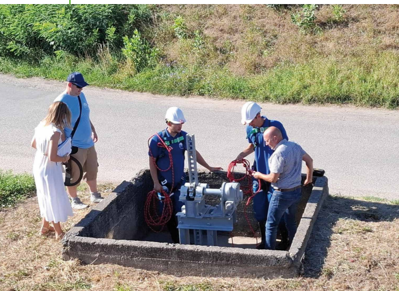
Beszállási engedéllyel elvégzett műtárgy ellenőrzés
