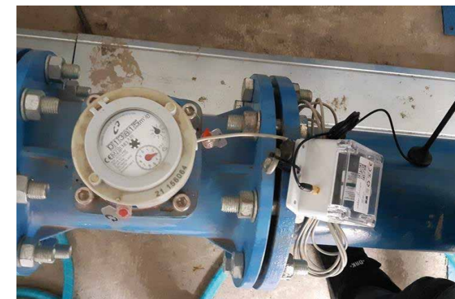
Vízmérő óra távleolvasó adapterrel
