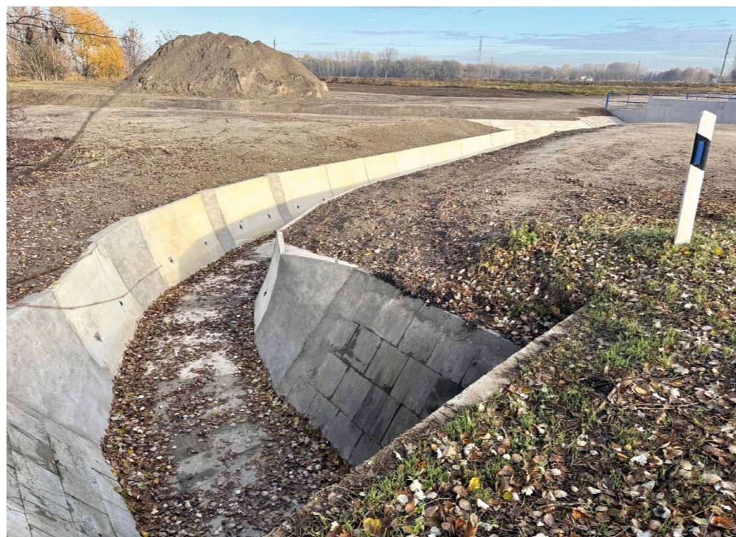
Kisiványszéki-csatorna 0+043 cskm tiltós átereszhez kapcsolódó TB elemek
