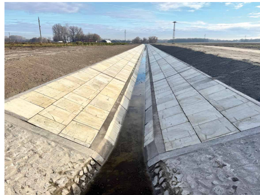
Mederburkolat a Domaszéki-főcsatornán
