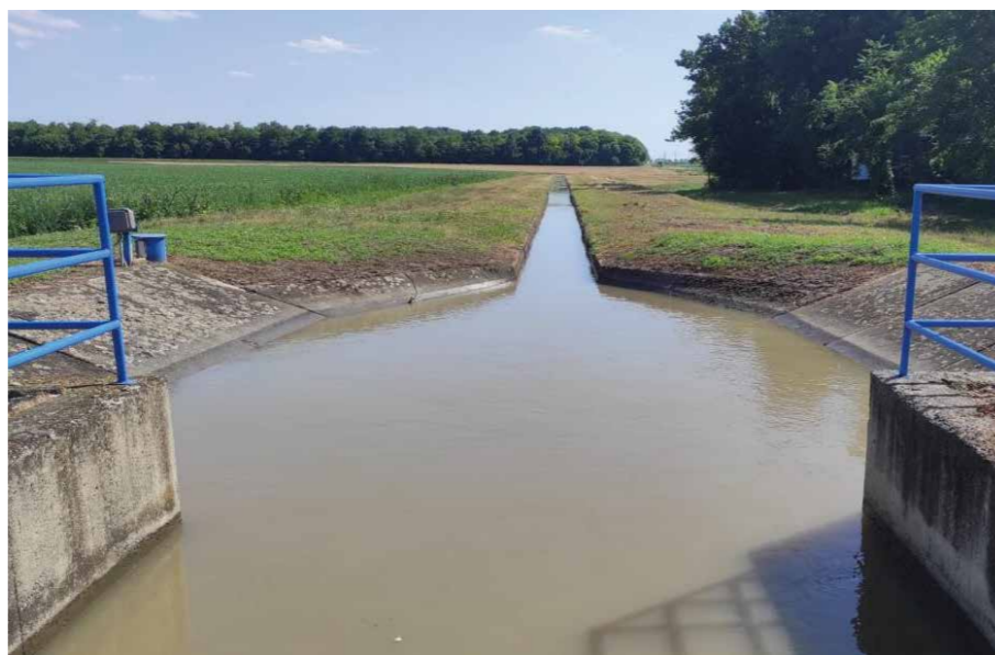
Beton burkolatú öntözőcsatorna
