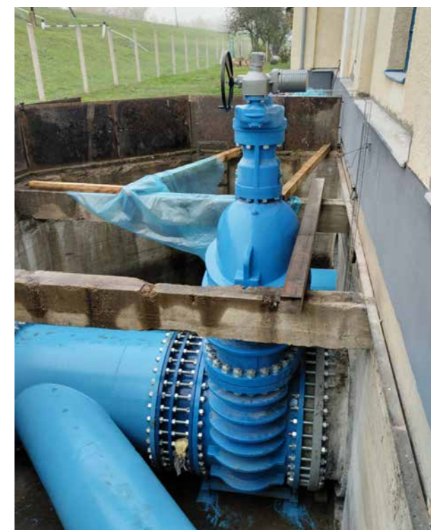
Györpölési szivattyútelep nadrágidom csere
