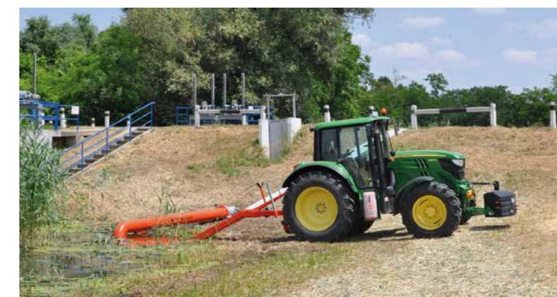
Ideiglenes vízáttemelés Veneroni szivattyúval
