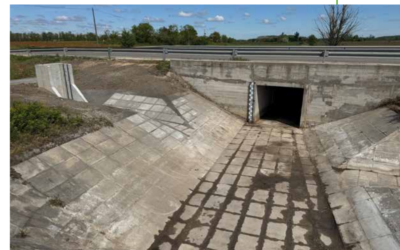
Az elkészült mederburkolatok és helyreállított oldalbeeresztő műtárgy
