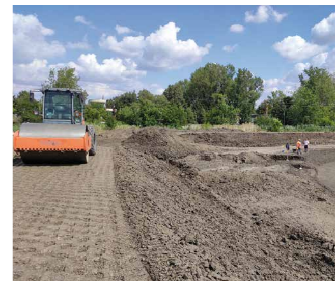
Hódtói záportározó töltésének építése
