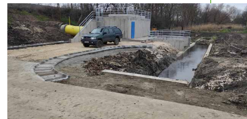
Hódtói szivattyútelep kapacitás bővítése
