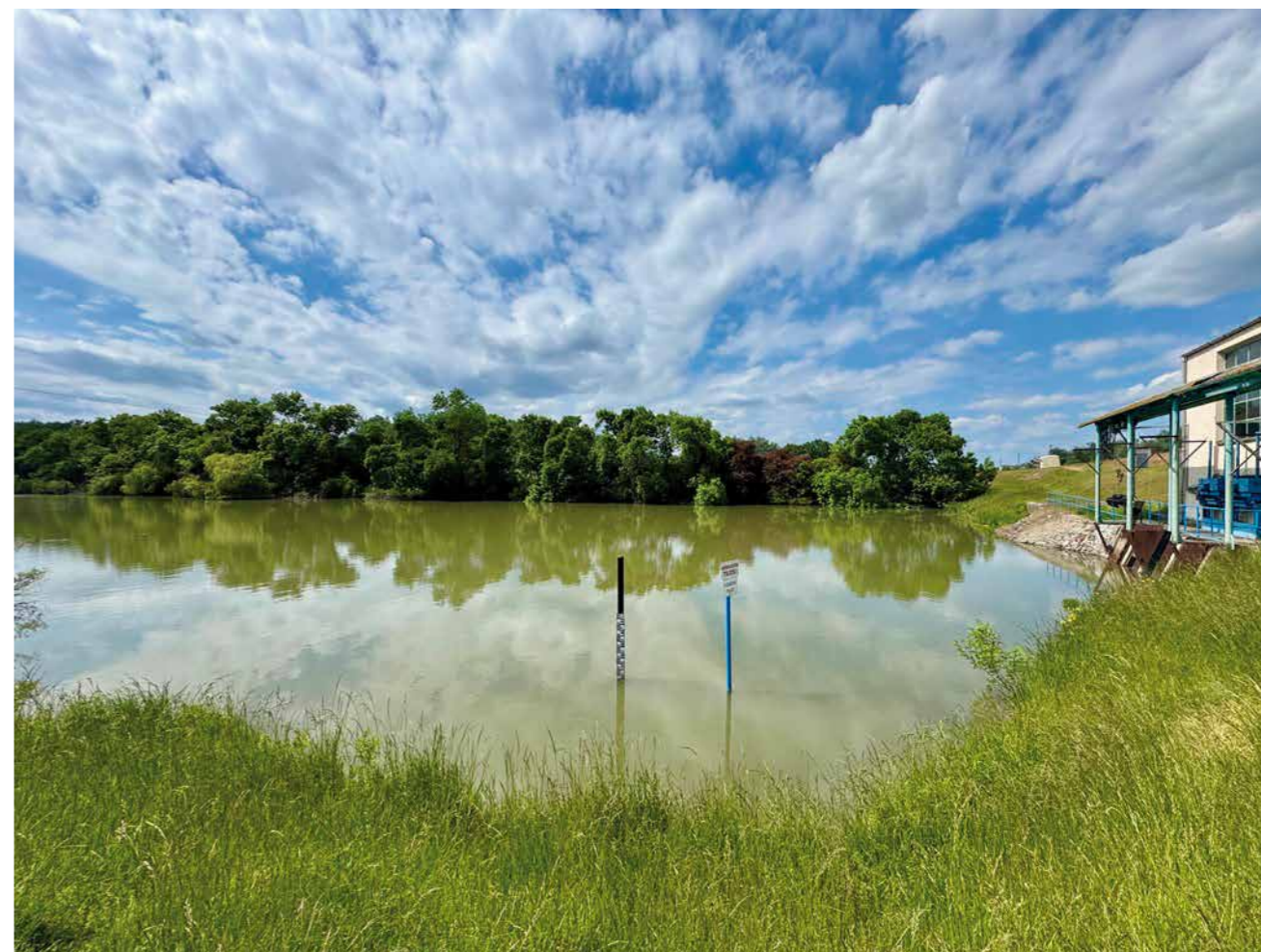
Algyői főcsatorna az Algyői szivattyútelep előtt
