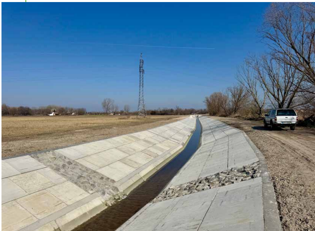
Az elkészült mederburkolat és vadátjáró
