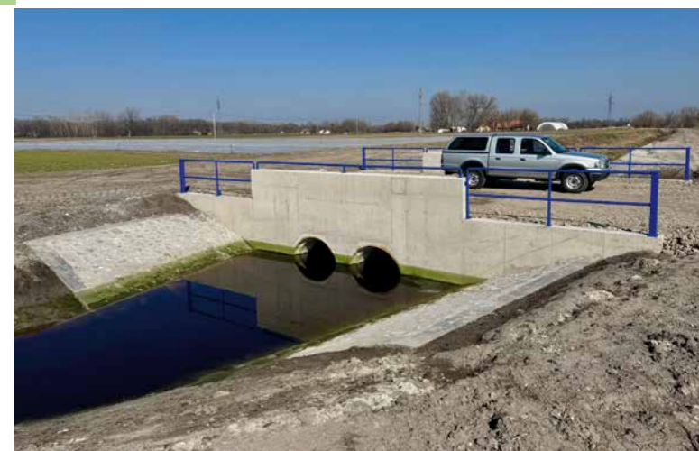
Az elkészült ikeráteresz a Domaszéki főcsatornán
