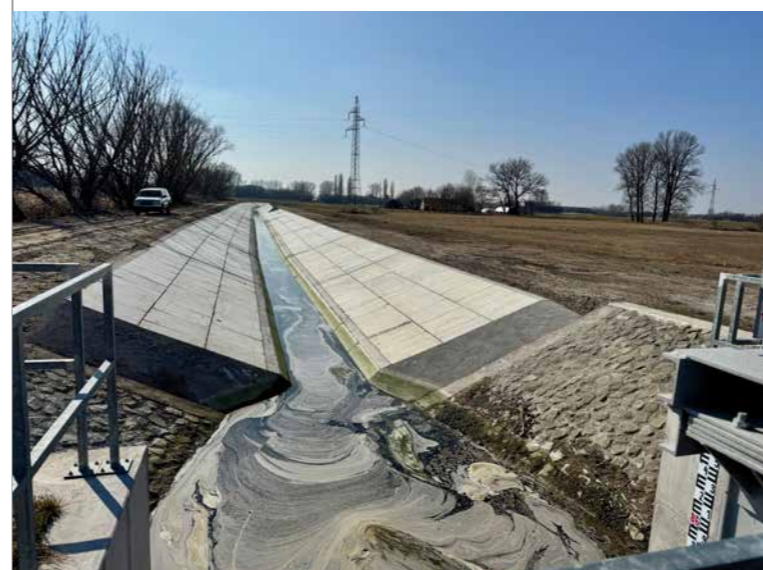
A Domaszéki főcsatorna új mederburkolatának kezdőszelvénye
