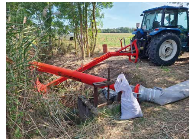
VENERONI szivattyú az ideiglenes elzárással lezárt tiltó felett
