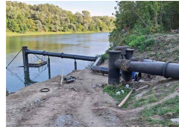
Csanyteleki vízkivétel bővítése
