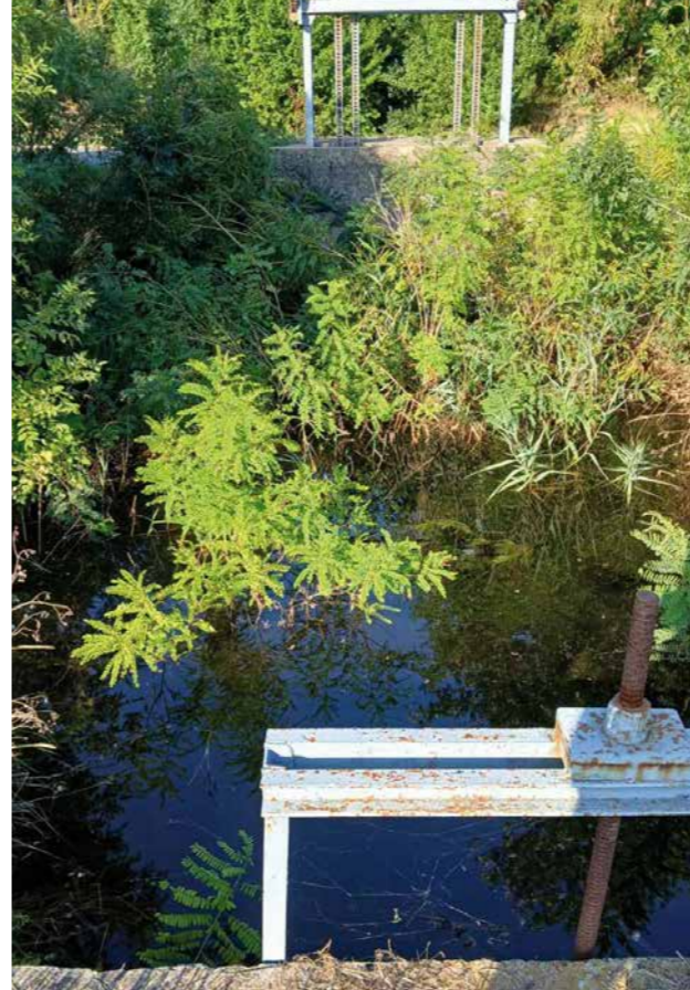
Szőlőhalom-Keselyesi megkerülő csatorna feltöltése 2025.08.20.
