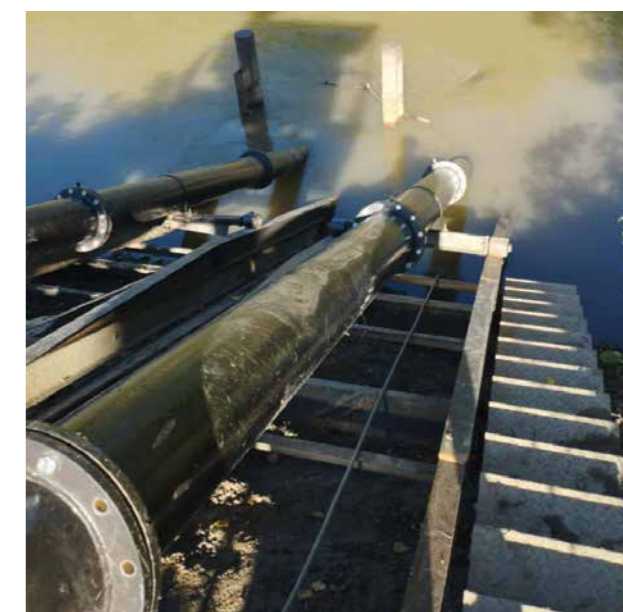
A beépített új sínrendszer
