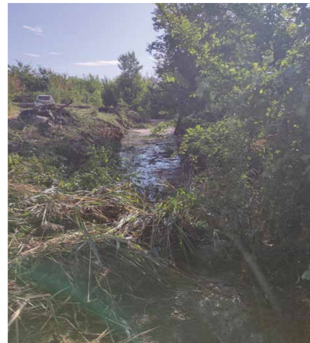
Páskum 1. csatorna vízfeltöltés 2025.07.08.
