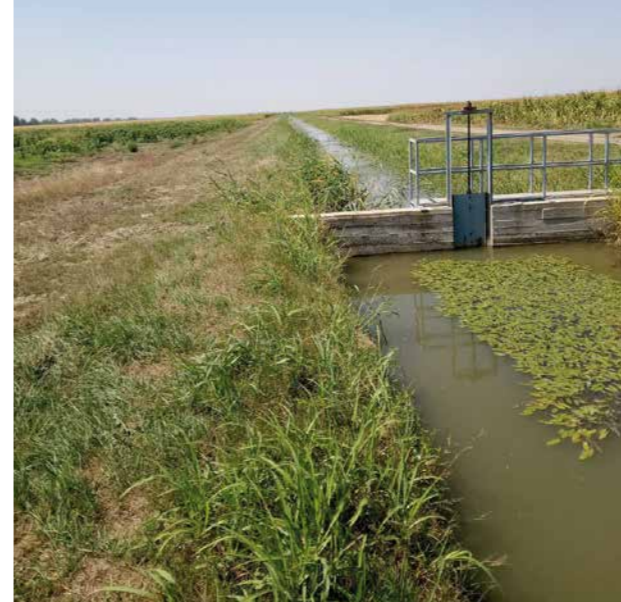
Cs-14 csatorna vízfeltöltés 2025.08.11.
