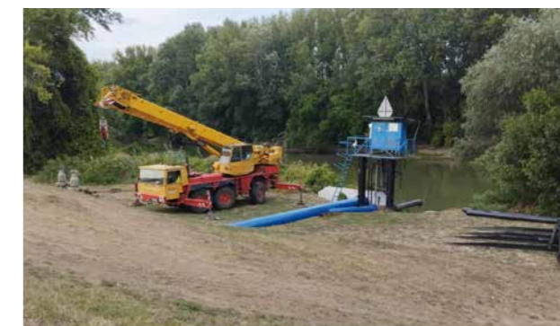
Daruzási munkák végzése az acélszerkezetek kiemelésékor
