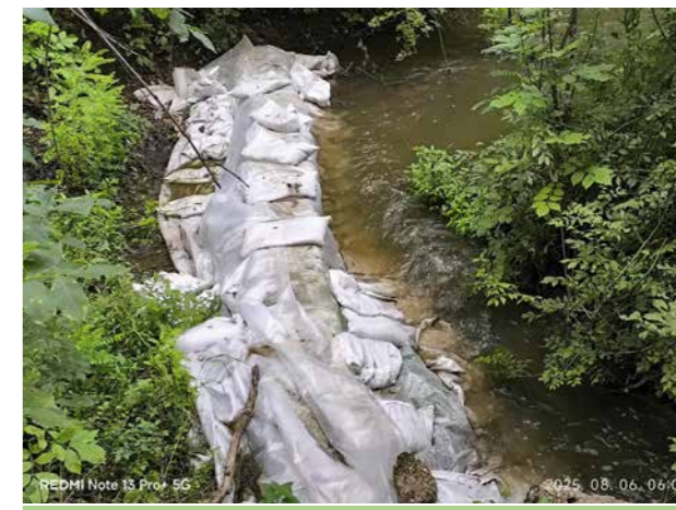
A Kéthalmi-csatorna felől a víz eléri a Nagyéri-főcsatornát (a homokzsákolással megakadályoztuk, hogy a víz a felvív irányba is elfolyjon)
