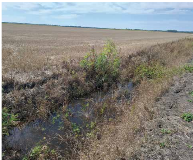
Matolai-csatorna 1+500 km szelvényben
