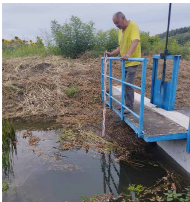
Ü-14 jelű csatorna vízpótlása; vízszint ellenőrzés a csatornán
