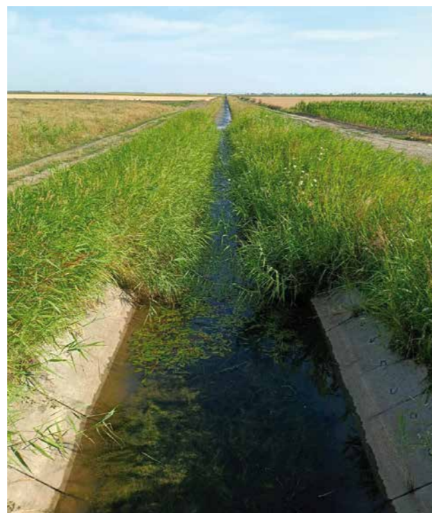
SV-11 csatorna vízfeltöltés 2025.07.15.
