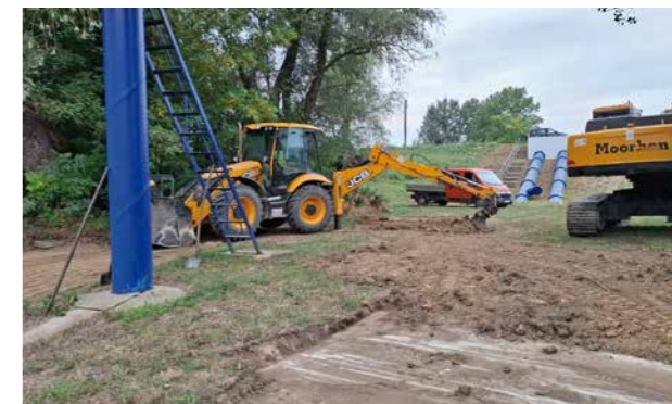
Vidreéri vízkivétel bővítési munkálatai
