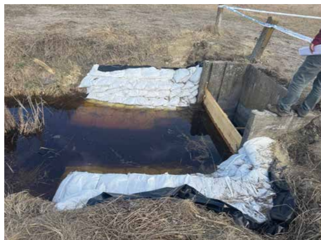
Domaszéki-főcsatorna 12+058 cskm szelvényében vízvisszatartás, pallós zárás rézsűvédelemmel
