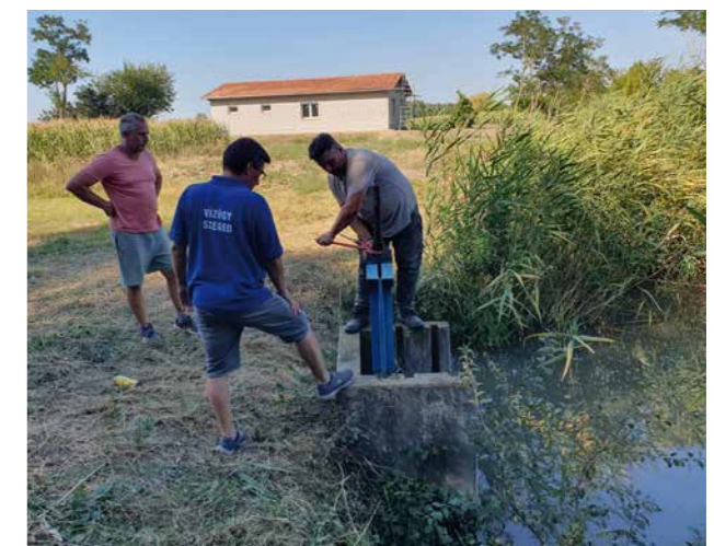
Matolai-csatorna torkolati tiltójának nyitása
