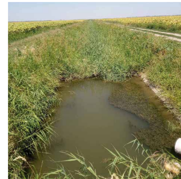
SV-12 csatorna vízfeltöltés 2025.08.11.
