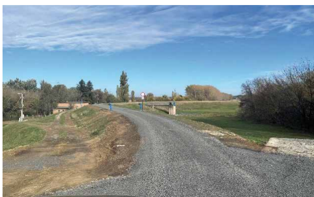
5. fénykép: Makadám útburkolat
