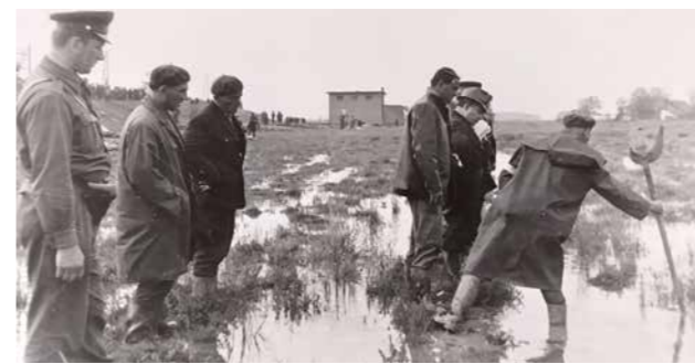
Árvízi védekezés a Körtevényesi szivattyútelep mellett 1970-ben
