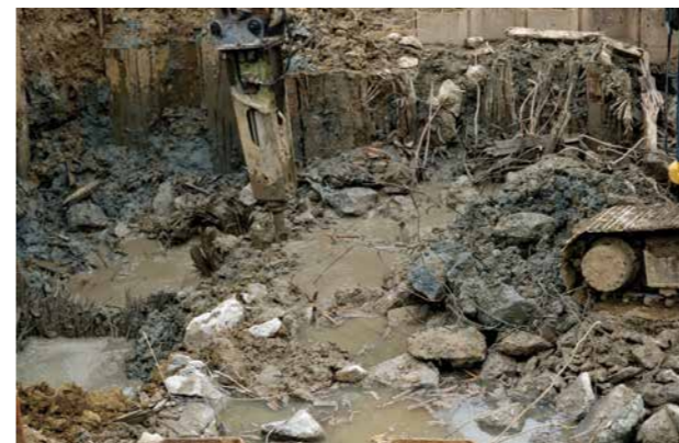
Régi fa zsaluzat az elbontott szivattyútelep helyén
