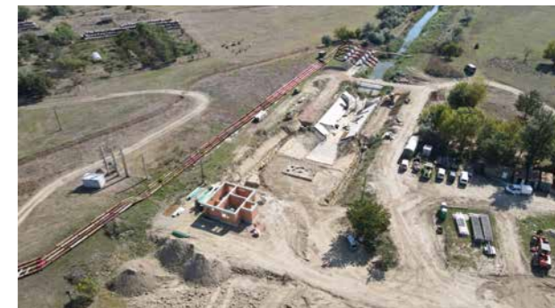
Szivattyútelep építés közben (2023)
