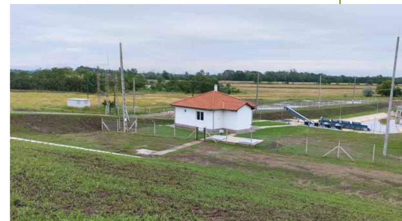
Az új Körtvélyesi szivattyútelep (2024)
