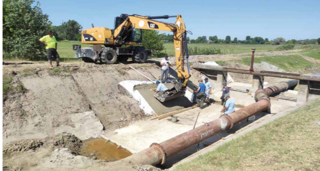
3. Rézsű betonozás
