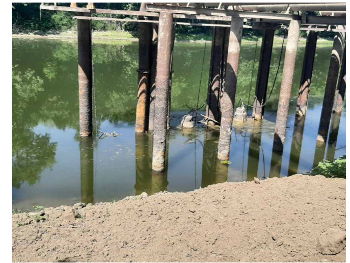
Nagytókei fővízkivétel - A biztonságos üzemhez a szivattyúkat el kellene lepnie a víznek, hogy biztos ne melegedjen túl
