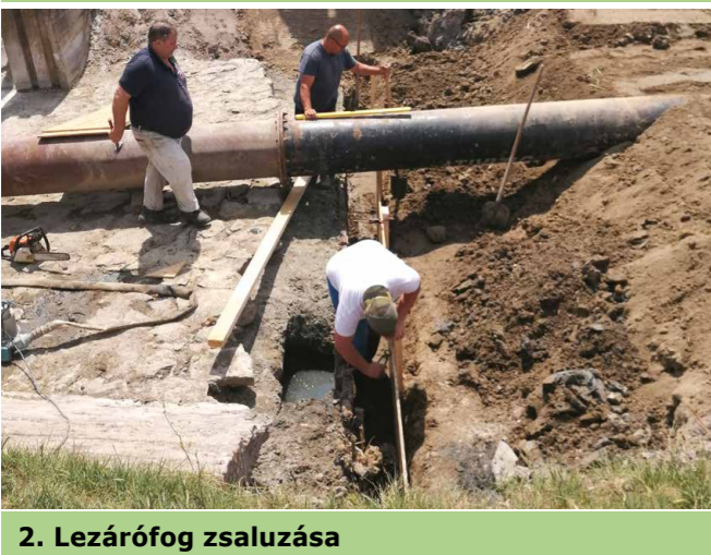
1. Zárófogat készítése
