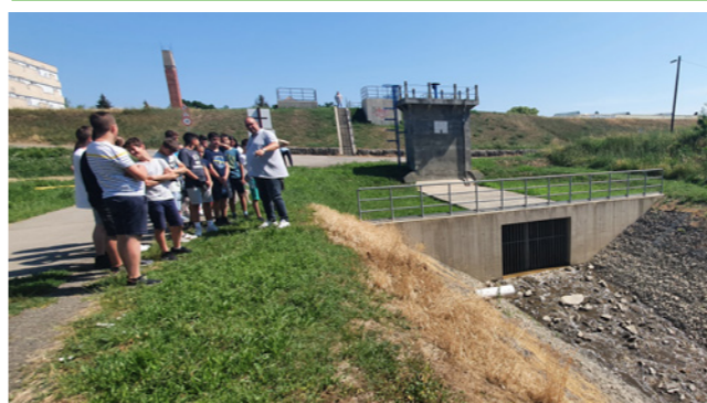
A szivattyútelep vízpróbája
