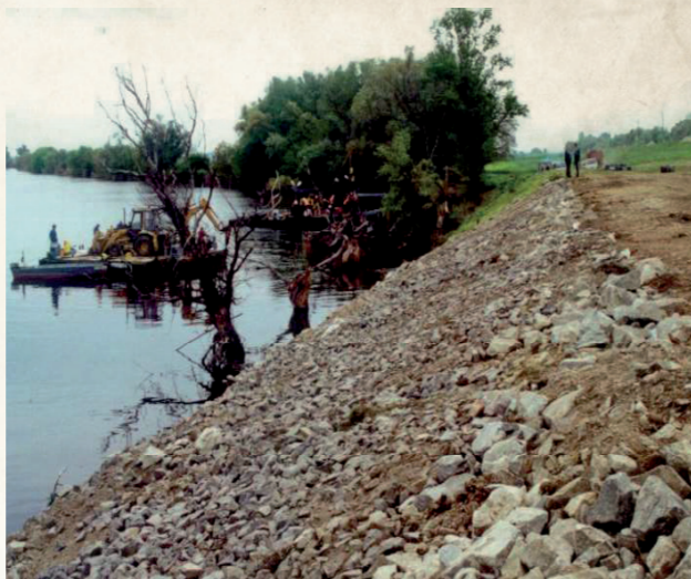
Szakadó part stabilizálás után
