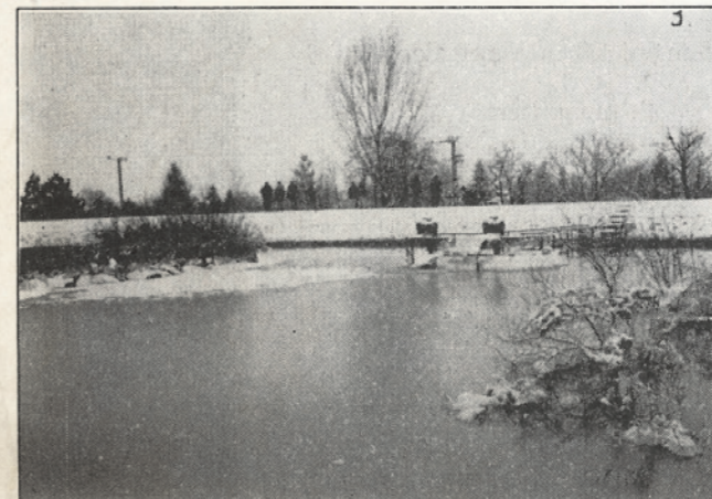
A szivattyútelep ellennyomó medencéje
