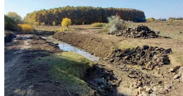
K-11 leürítő csatorna a munka megkezdésekor
