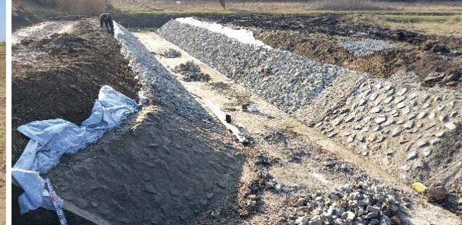
K-11 leürítő csatorna burkolása
