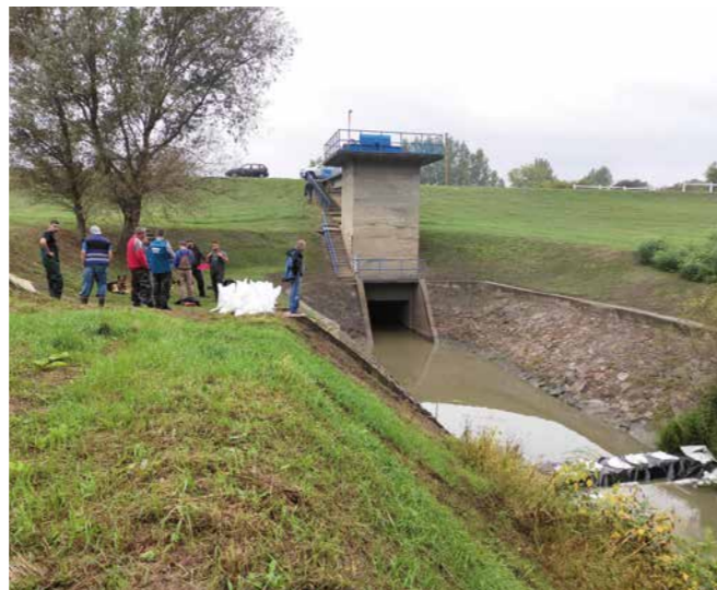
A Vidre-éri szivattyútelep előkészítése a szemlére
