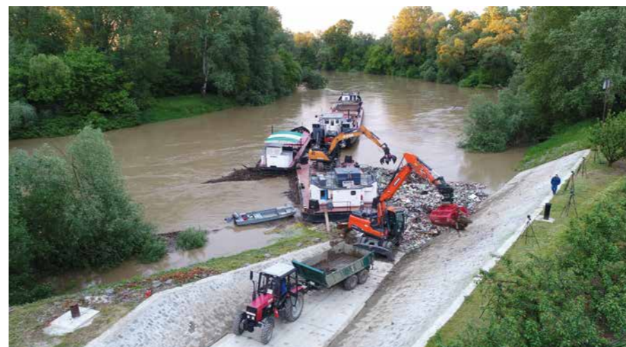
Részleges mederelzárással dolgozik a géplánc
