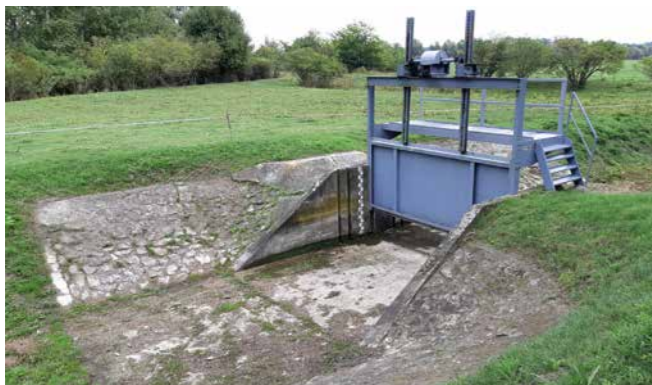
Vízkormányzó műtárgy, Körös-ér 21+800 km
