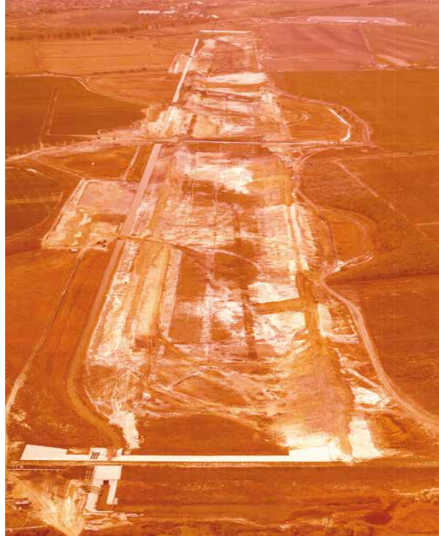
A pálya építés közben
