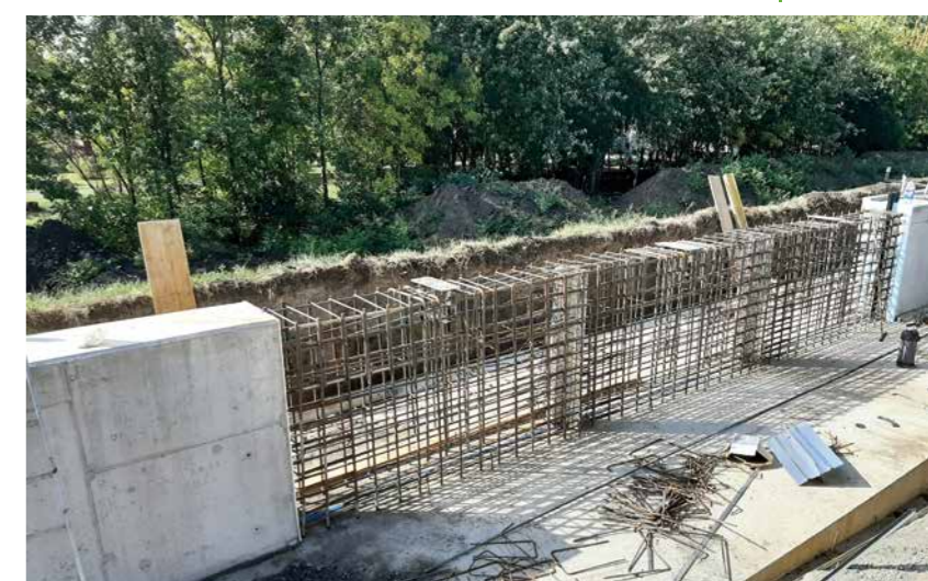
Az új vasbeton szögtámfal építése
