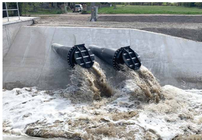
Ivánszéki szivattyútelep üzempróbája (4.)
