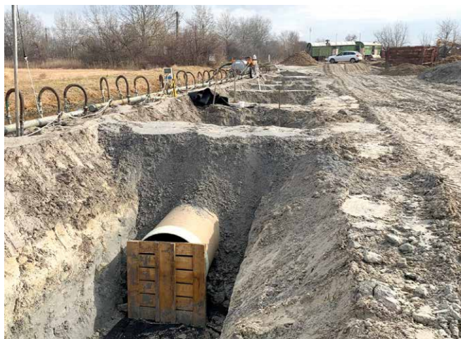
HOBAS cső fektetése (3.)
