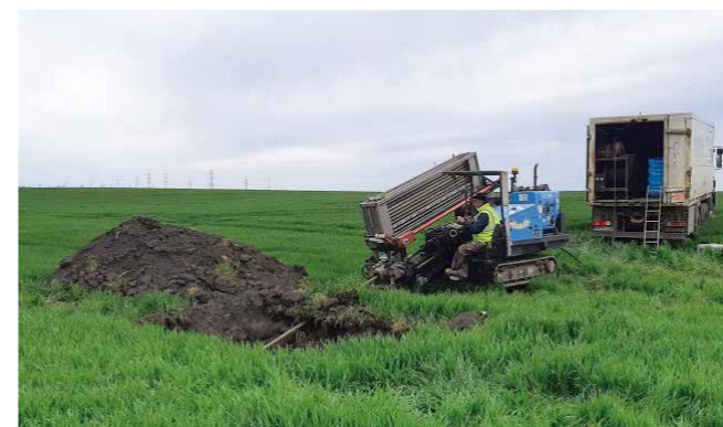
Földkábel vezetés Orosháza térségében a Hajdúér-Görbedi-csatornán
