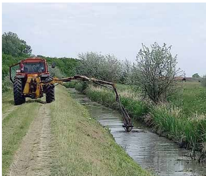
Mederkapálás a K-1 öntözőcsatornán
