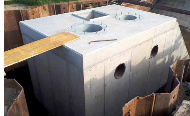
Szivattyúakna építése (7.)
