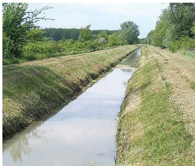
K-1 öntözőcsatorna tisztított szakasza
