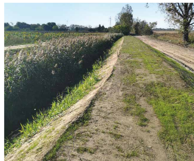
Töltésépítés a Domaszéki-főcsatornán
