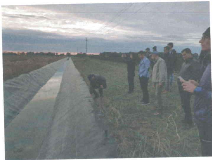
A fóliaszigetelt Mezőhegyes-Peregi átkötő csatornát is szemrevételezték
