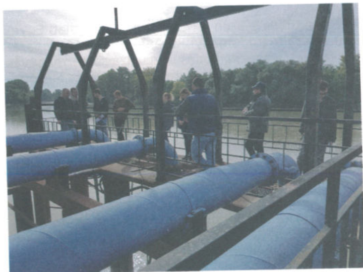
Látogatás a Cservölgyi fővízkivételi műnél
