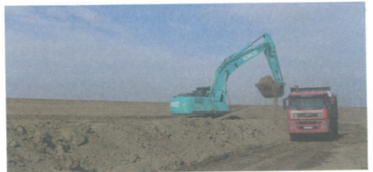
A régi töltés agyagmagjának elbontása
