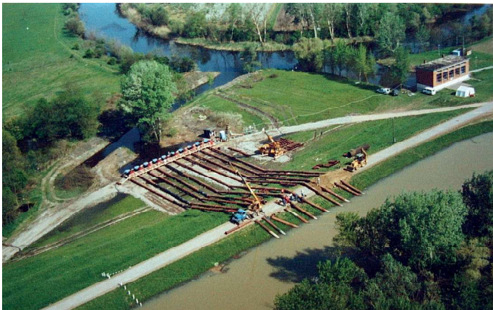
Provizórium a Mindszent II. szivattyútelepnél
