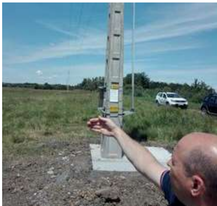
22 KV vezeték kiváltása műszaki átadás
