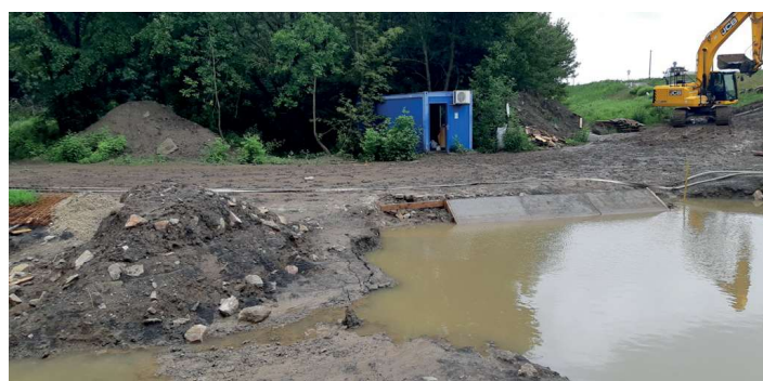
Építési munkálatok a Makói szivattyútelepenél
