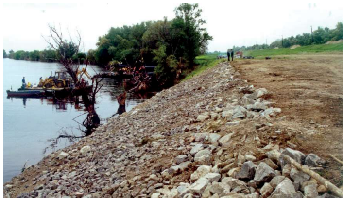
Szakadó part stabilizálás után
