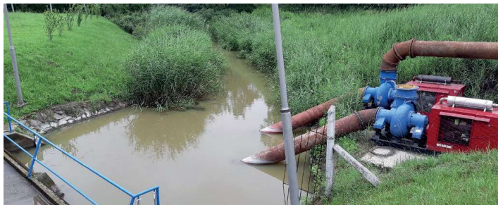
Provizórium az átépítés alatt lévő makói szivattyútelepen
