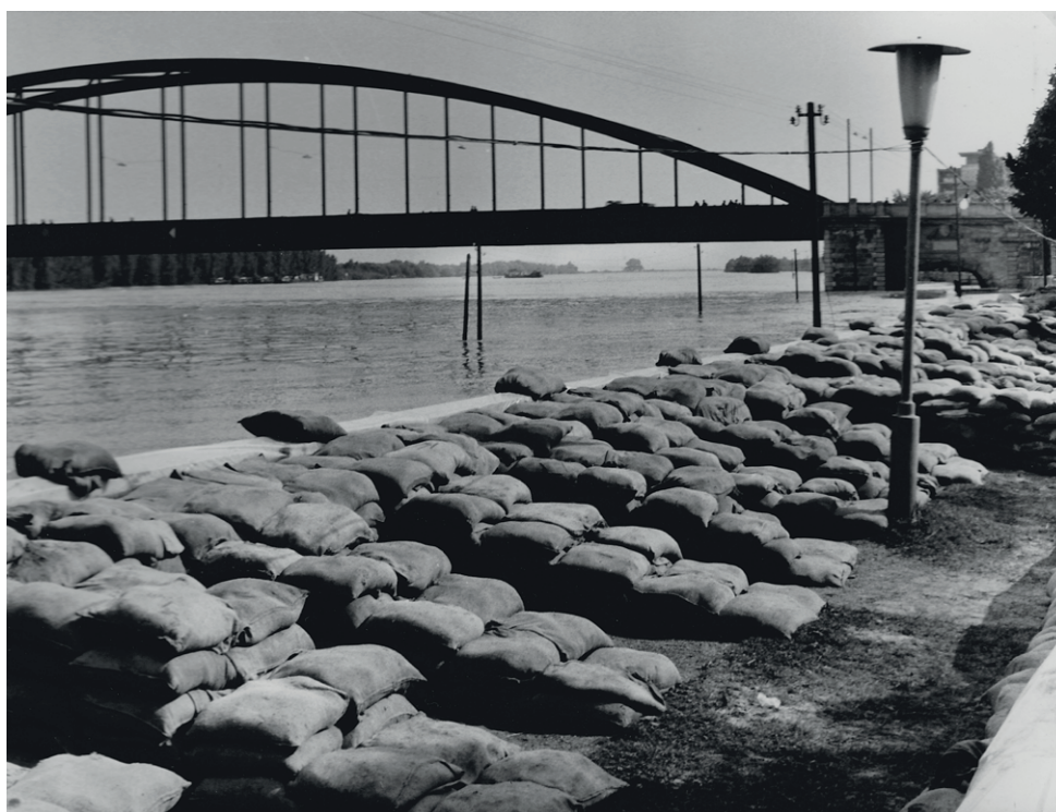
A parapetfal megtámasztása a szegedi híd felett
