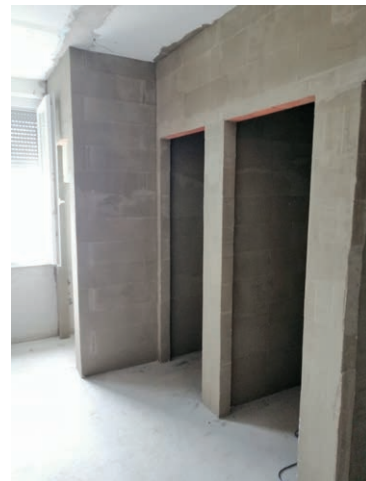
Az Irinyi utcai épület mellékhelyiség felújításának jelenlegi állapota
