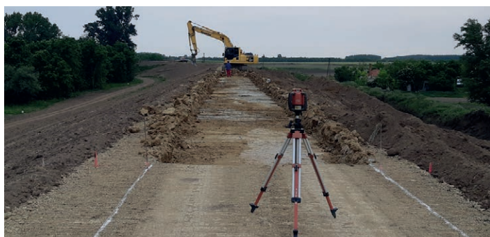
Útburkolat előkészítése a Hármaskörös töltésen
