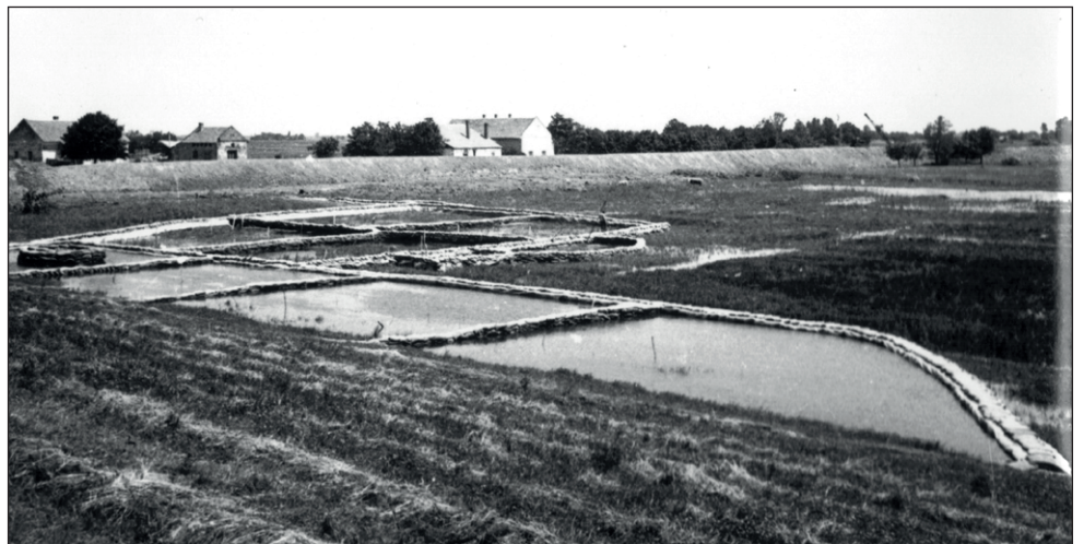
Szorítógáták és lokalizációs töltés Zalotánál
