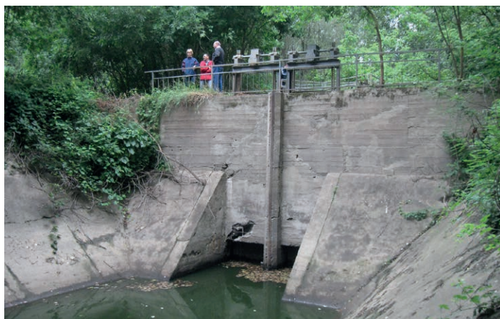
Az elavult mártélyi ikerszelvényű tiltós átereszt
