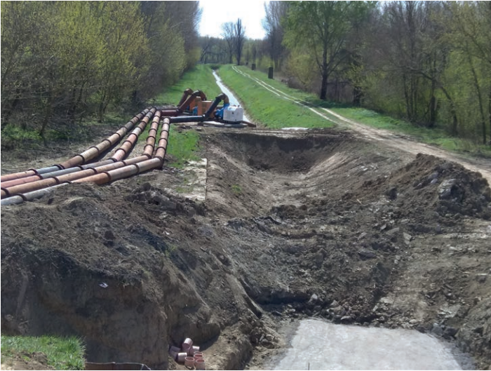
Telepített provizórium a Makói szivattyútelepnél
