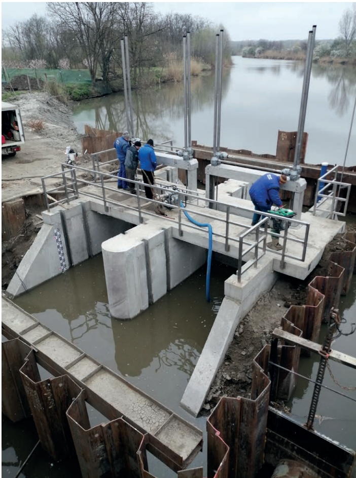
Víztartási próba a zsiliptáblák behelyezése után
