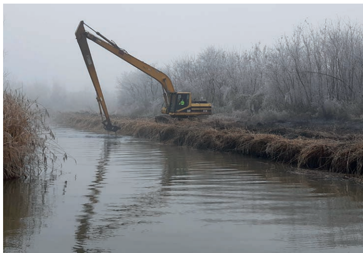
Egyoldali kotrás a téli időszakban
