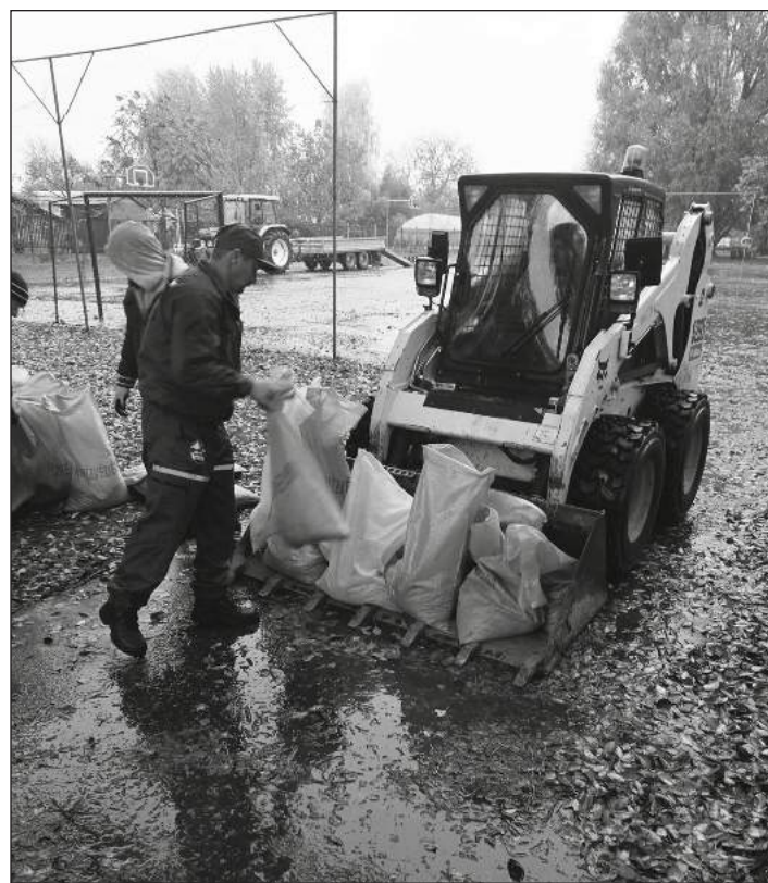
Homokzsák rakodása a készülő védőfalhoz
