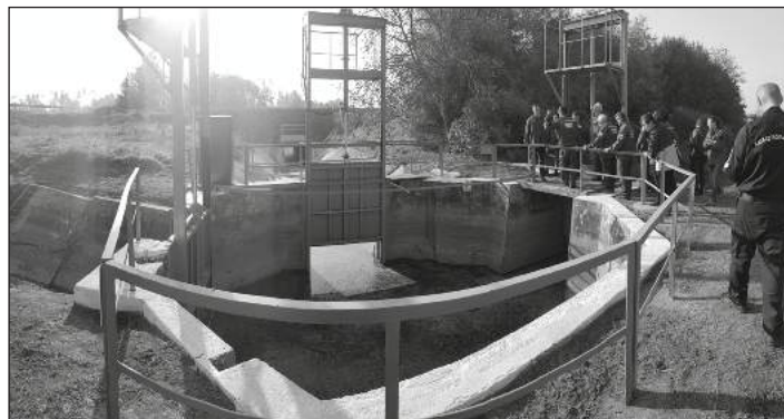
Műtárgy ellenőrzés a Hódmezővásárhelyi Szakaszmérnökség területén
